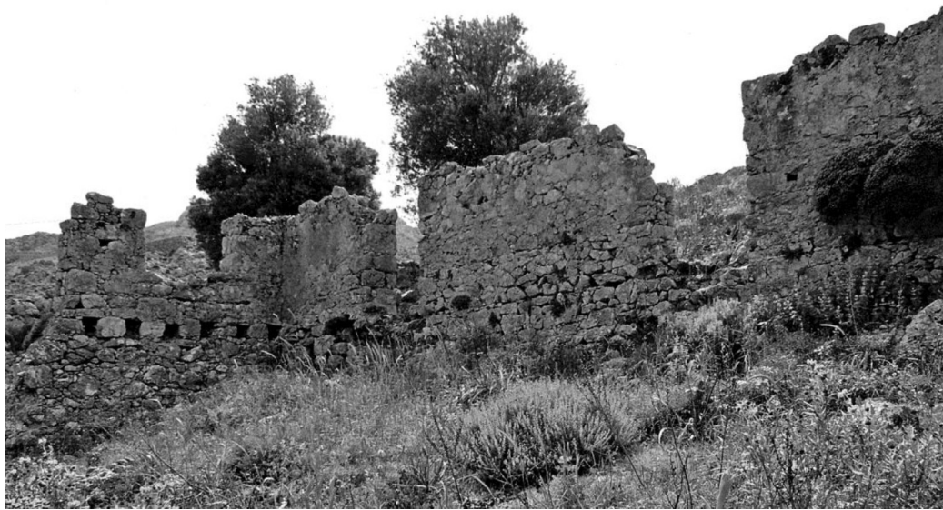
Εικ. 6 Κάλυμνος. Δίπατο οικοδόμημα στη νότια πλευρά του παλαιοχριστιανικού οικισμού στον κόλπο της Ρίνας (θέση Ελληνικά). Άποψη από τα βορειοδυτικά.
