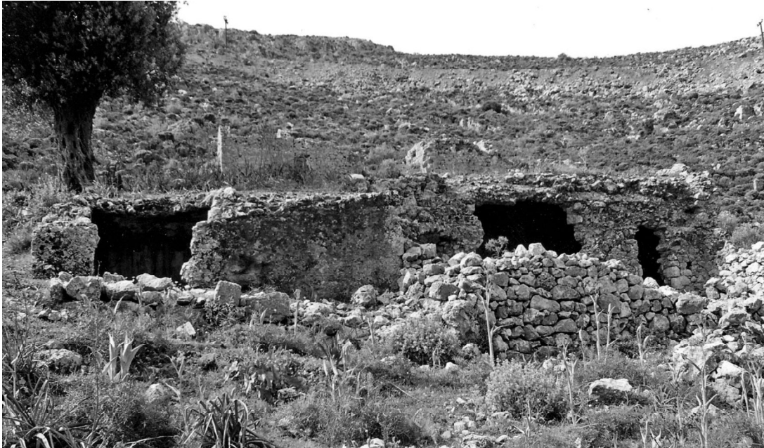
Εικ. 4. Κάλυμος. Ισόγειο οικοδόμημα στη νότια πλευρά του παλαιοχριστιανικού οικισμού στον κόλπο της Ρίνας (θέση Ελληνικά). Άποψη από τα βόρεια.
