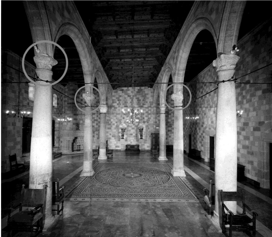
Εικ. 5. Ρόδος, Παλάτι Μ. Μαγίστρου. Τρία λεβητοειδή κιονόκρανα (σε κύκλο) από τη βασιλική της Αγ. Ειρήνης στην Αρνίθα
