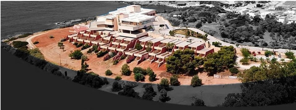
Εικ. 6. Σχολή και Ξενοδοχείο Τουριστικών Επαγγελματιών στην Ανάβυσσο, Αρχιτέκτονας Α. Τομπάζης, Τμήμα διαφήμισης του Υπουργείου Τουρισμού για σπουδές στο ΙΕΚ Αναβύσσου. Πηγή: Ιστοσελίδα Υπουργείου Τουρισμού.
