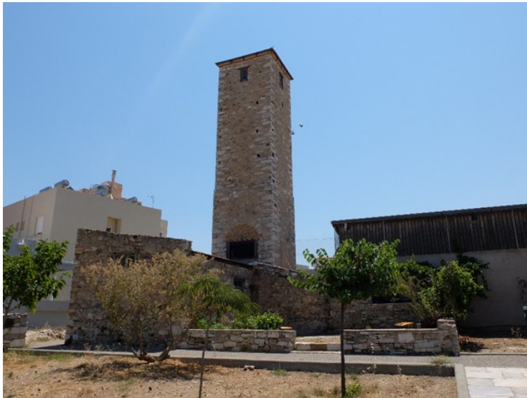
Εικ.3 Το σκαγάδικο Αναιρούση, κτίριο που αποκαταστάθηκε στα πλαίσια του έργου του ΚΕΤΕΠΟ, παρέμεινε κλειστό για χρόνια λόγω προβληματικής διαχείρισης. Πηγή: Αρχείο Δ. Χατζή Ροδοπούλου
